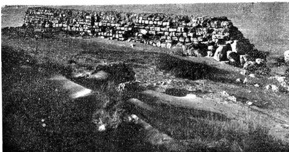
Dique del antiguo puerto
